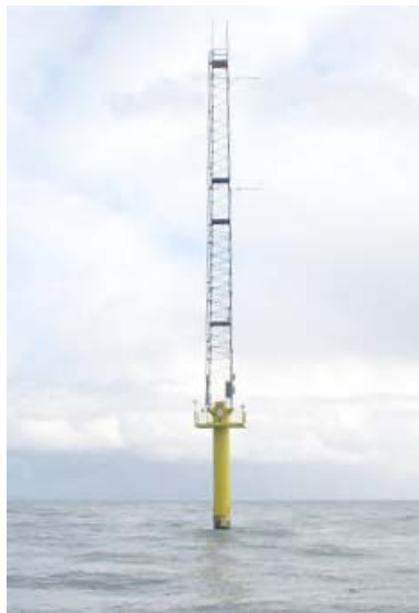
Figure 4 : Arklow Bank Met Mast
